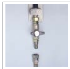
stadiko miejsce poboru HD: Wysokociśnieniowe miejsce poboru do szybkiego podłączenia i odłączenia węzła ruchomego.
